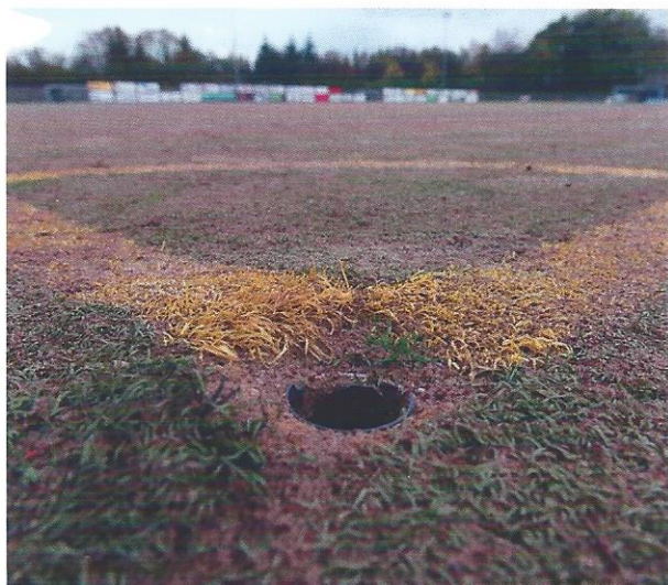
Grau, aufgewölbt, unansehnlich, mehr Sand als Rasen: Dieses traurige Bild bietet der Kunstrasenplatz an der Köhlerwaldstraße in- zwischen. Foto: Tim Müßle
